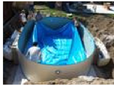
Symbolfoto Gleichmäßige Auslegung der Schwimmbadfolie aus der Beckenmitte.
