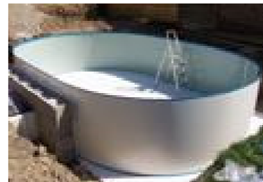
Symbolfoto Ovalbecken mit Stützmauer und 2 cm Styroporhinterfüllung; Becken aufgebaut mit unterlegtem Hakenfalzplatten
