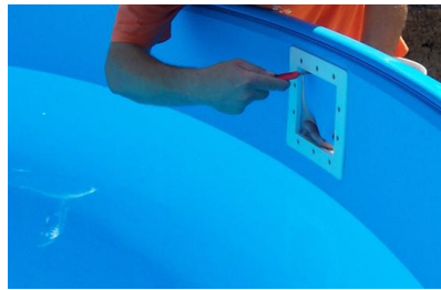
Symbolfoto Symbolfoto Skimmer: Flansch nur mit Schraubenzieher (kein Akku-Schrauber) befestigen. Folie erst schneiden, wenn fertig verflanscht und wenn Wasserstand genügend hoch ist!
